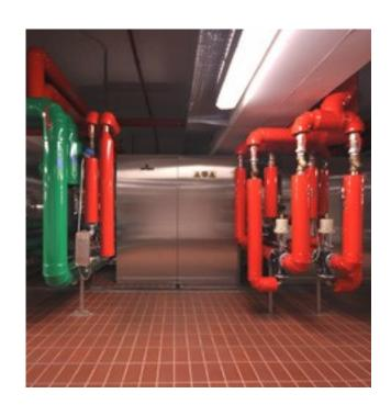
воздуховода, непрерывно регулирует исполнительное устройство линейного перемещения и система заслонок, в результате чего создается воздушная стена, которая постоянно перемещается внутри камеры, обеспечивая лучшее вяление критических участков окорока; кроме того, для воздушной стены можно задавать промежуточные точки остановки и длительность самих остановок. Удаление воздуха происходит через потолочные воздуховоды с регулируемыми воздухозаборниками.
